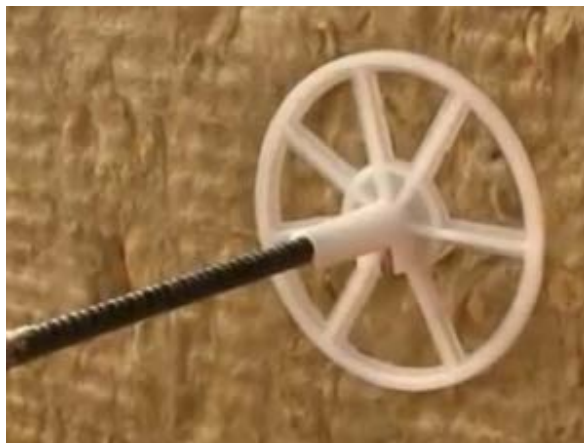
Նկար 30. Ճկուն կապի տեղակայման սխեմա
