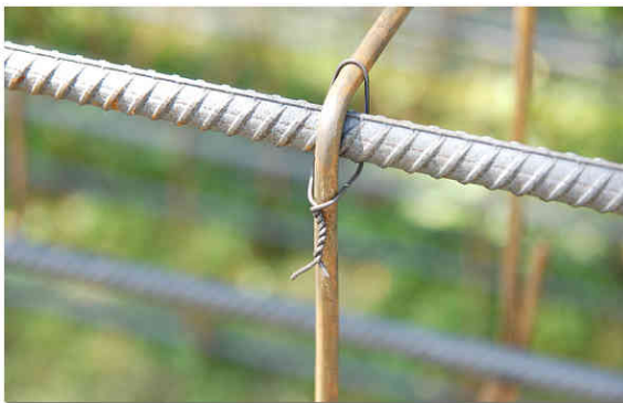
Նկար 5. Ձեռքով և ավտոմատացված ատրճանակով ձողերի կապում
