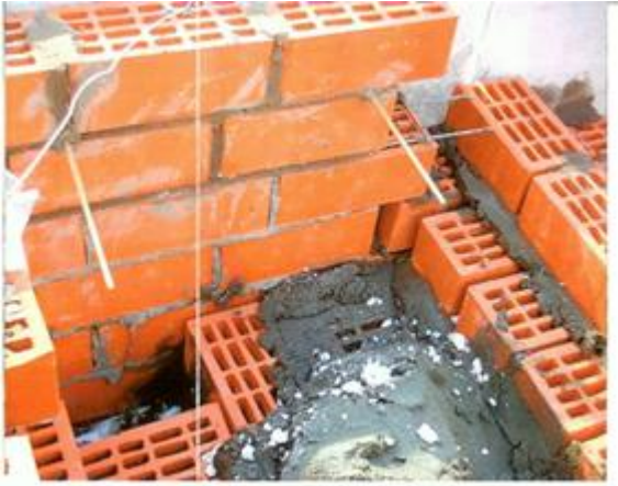
Նկար 6. Աղյուսե (քարե) շարվածքի կարերում ՈՄԿԱ-ից ճկուն կապերի տեղադրման դրվագ
