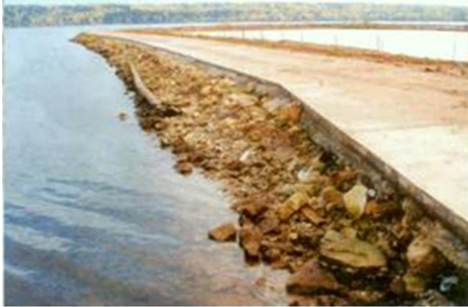
Նկար 22. Կիսապատնեշի կառույց՝ կոմպոզիտային ամրանի կիրառմամբ
