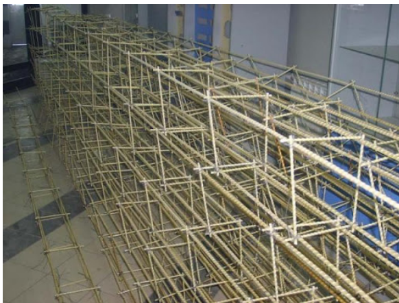
Նկար 3. ՈՄԿԱ-ով ծավալային ամրանակմախքներ
