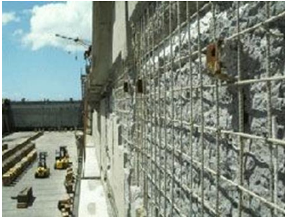
Նկար 11. ՈՄԿԱ-ից ցանց փոստրակի ամրակվող պատի ծածկույթի տակ
