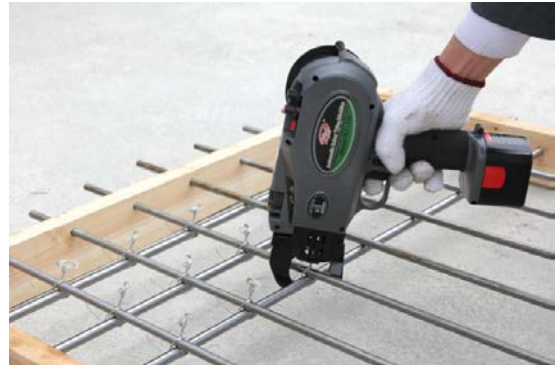
Նկար 5. Ձեռքով և ավտոմատացված ատրճանակով ձողերի կապում
