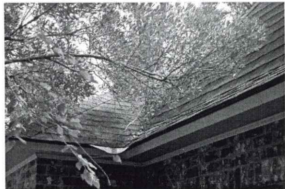
Նկար 4. Տանիքին հարակից ծառերի ճյուղերի ոչ պատշաճ տեղակայման օրինակ
