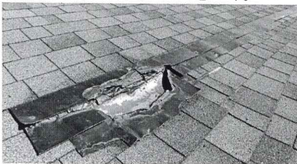
Նկար 2. Տանիքի պաշտպանիչ ծածկույթների օրինակ
