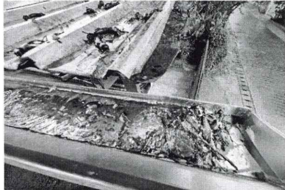
Նկար 1. Խցանված ջրահեռացման համակարգերի օրինակ
