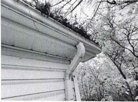
Նկար 1. Խցանված ջրահեռացման համակարգերի օրինակ
