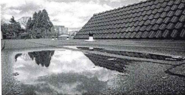
Նկար 3. Տանիքի մակերևույթին ջրի լճացման օրինակ
